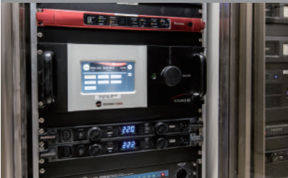
조정실에 위치한 IOSONO Core system. WFS 음장을 형성하는 핵심 장비이다.
